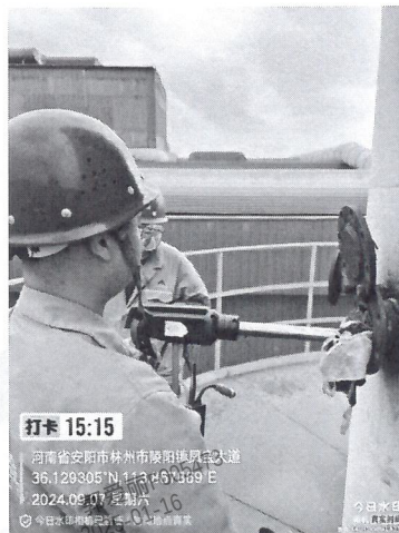
钢渣处理排气筒出口
