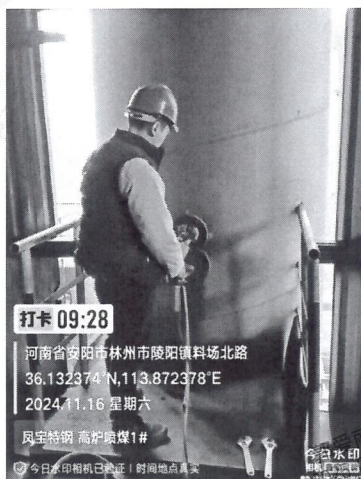
高炉煤粉制备1#排气筒出口
